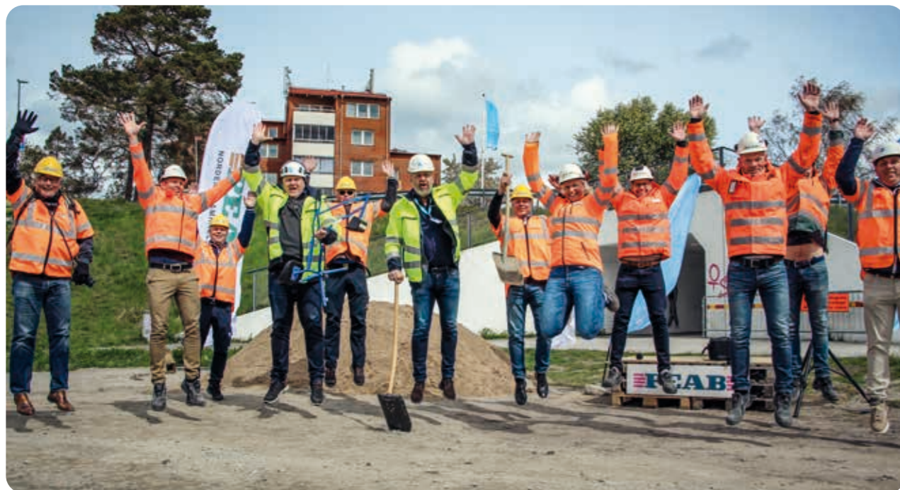
Första spadtaget på Hyresrätterna Solgårdsterrassen. Foto: Annika Sahlin.
