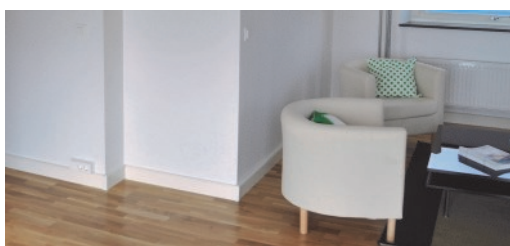
Folierad mdf med integrerat elkablage.
